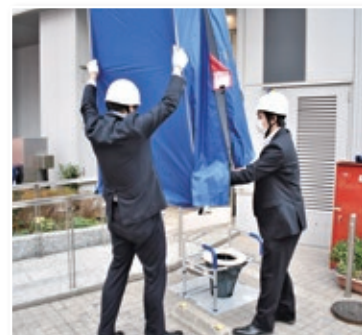
仮設トイレ設置の様子
